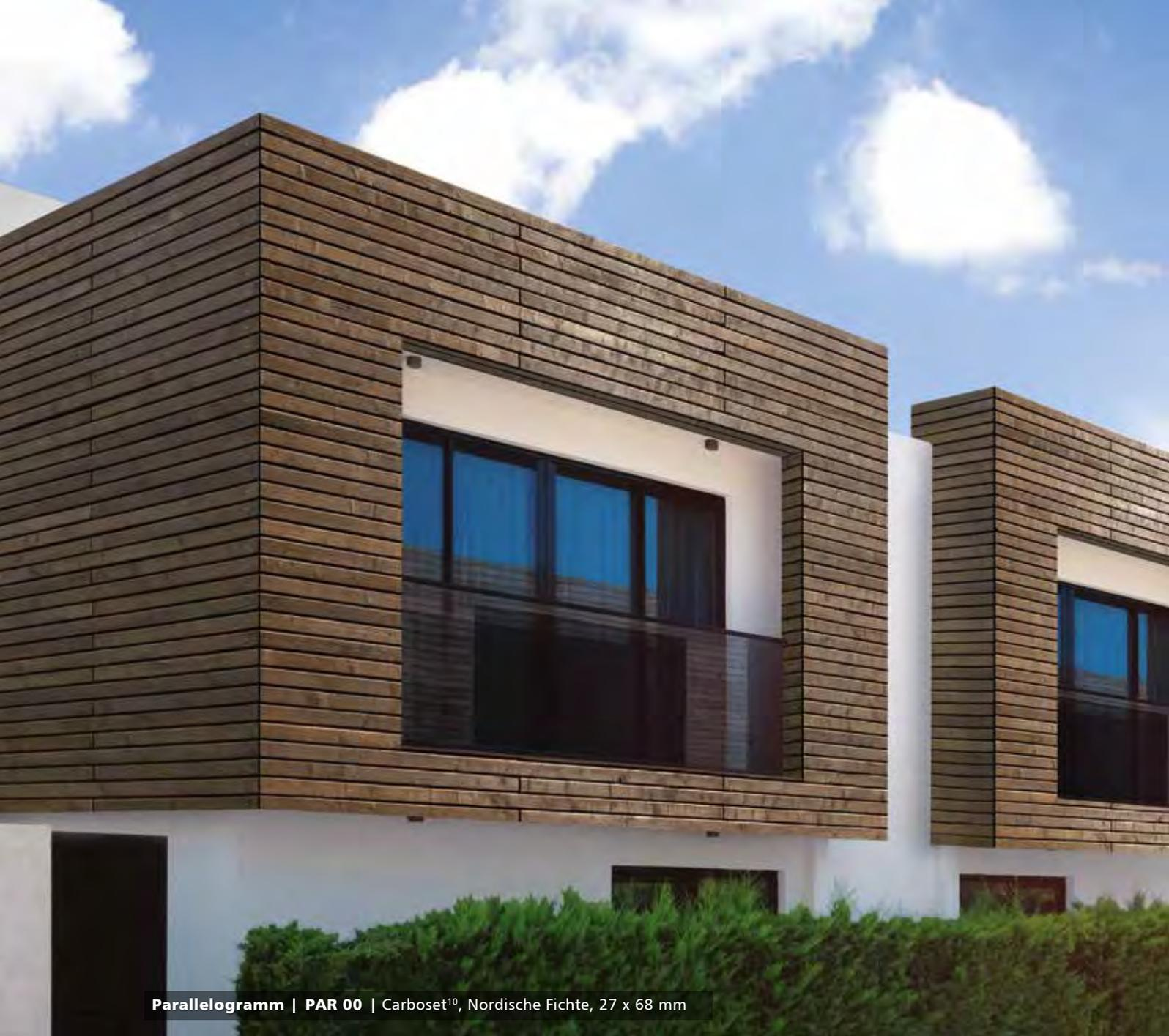
**Parallelogramm | PAR 00 | Carboset<sup>10</sup>, Nordische Fichte, 27 x 68 mm**
